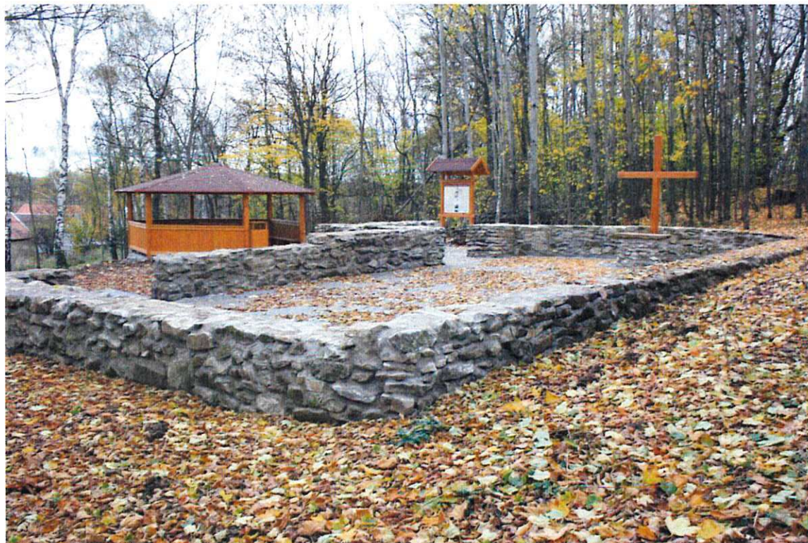
Třemešné, vykopané a upravené zříceniny kostela v roce 2013, pouhých 31 let po jeho zbytečné likvidaci (foto Z. Procházka)
