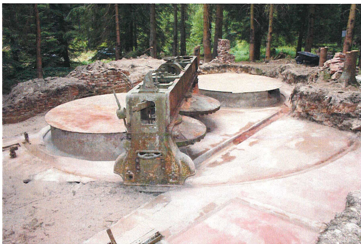
Česká Ves – Arnoštova leštírna, místnost s leštírenským strojem po vyklizení suti v červenci 2013 (foto Z. Procházka)
