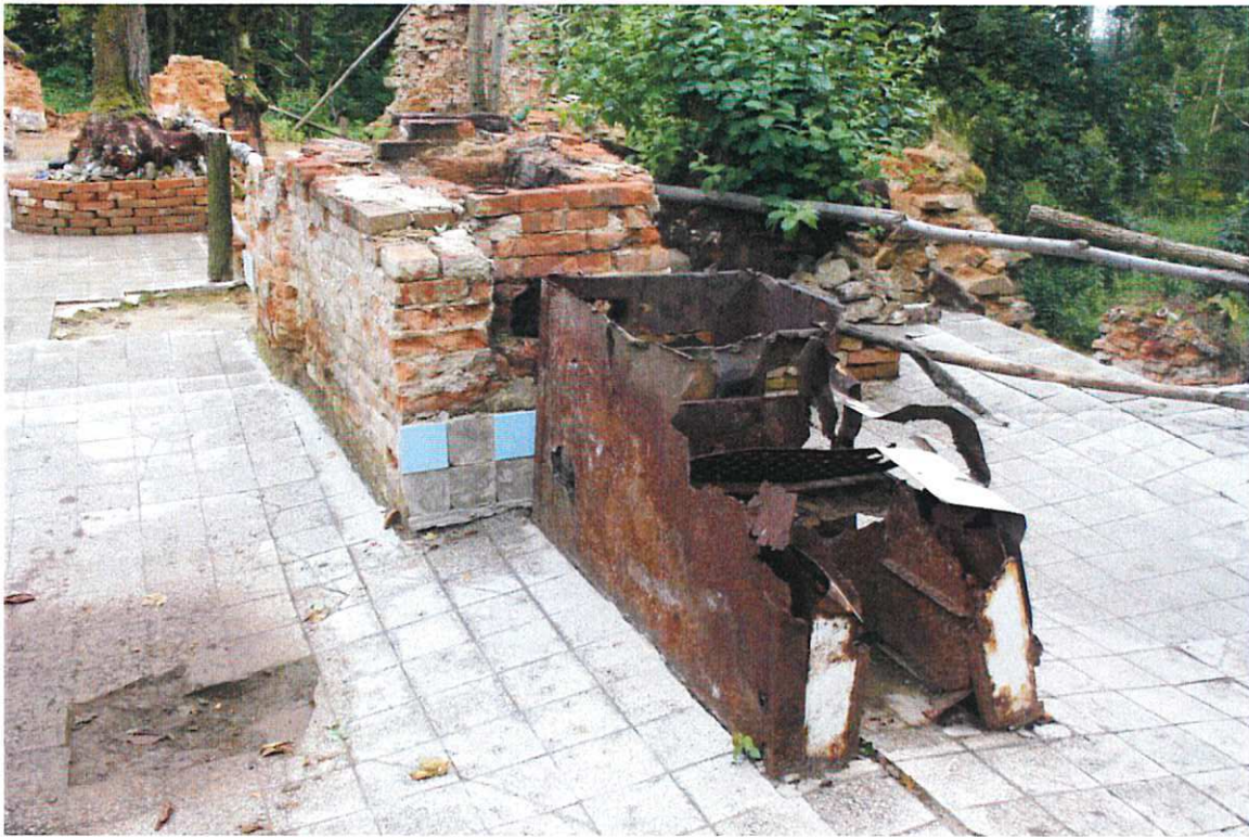
Lučina, zřícenina čp. 26, prostor bývalé kuchyně PS se zbytky kuchyňského sporáku (foto Z. Procházka 2014)
