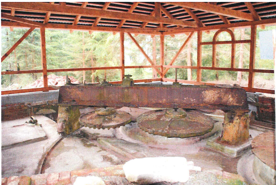
Česká Ves – Arnoštova leštírna, interiér přístřešku po dokončení v březnu 2015 (foto Z. Procházka)
