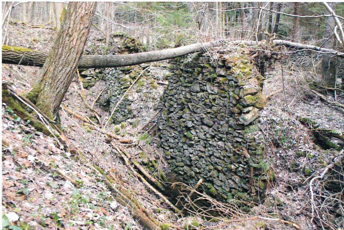
Leštírna č. 3, současný stav zříceniny (foto Z. Procházka)
