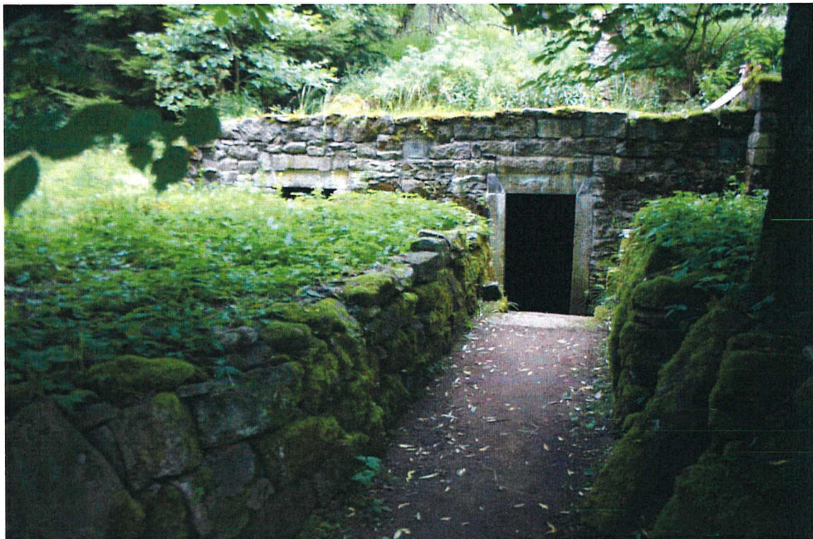
Česká Ves, Josefovo údolí, upravené zříceniny v roce 2008 (foto Z. Procházka)
