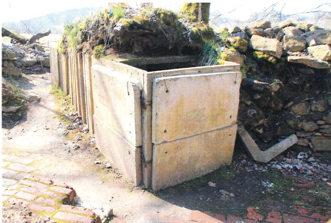
Lučina, bunkr československé armády zakopaný do zbořeného pivovaru, jehož betonový panel je datován datem výroby 7. 4. 1960
