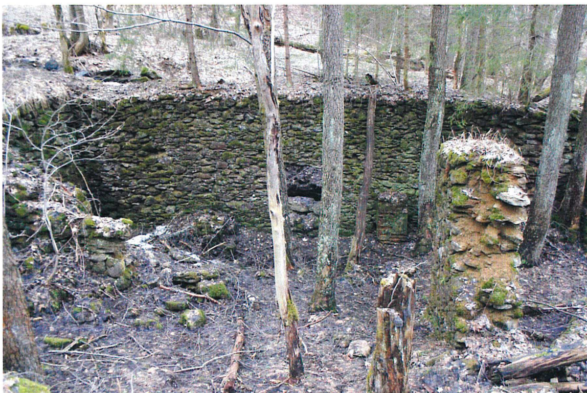
Pila, zbytky vodního provozu rodiny Brunner patří k nejlépe dochovaným pozůstatkům průmyslových objektů v zaniklých vsích domažlické části Českého lesa (foto Z. Procházka)
